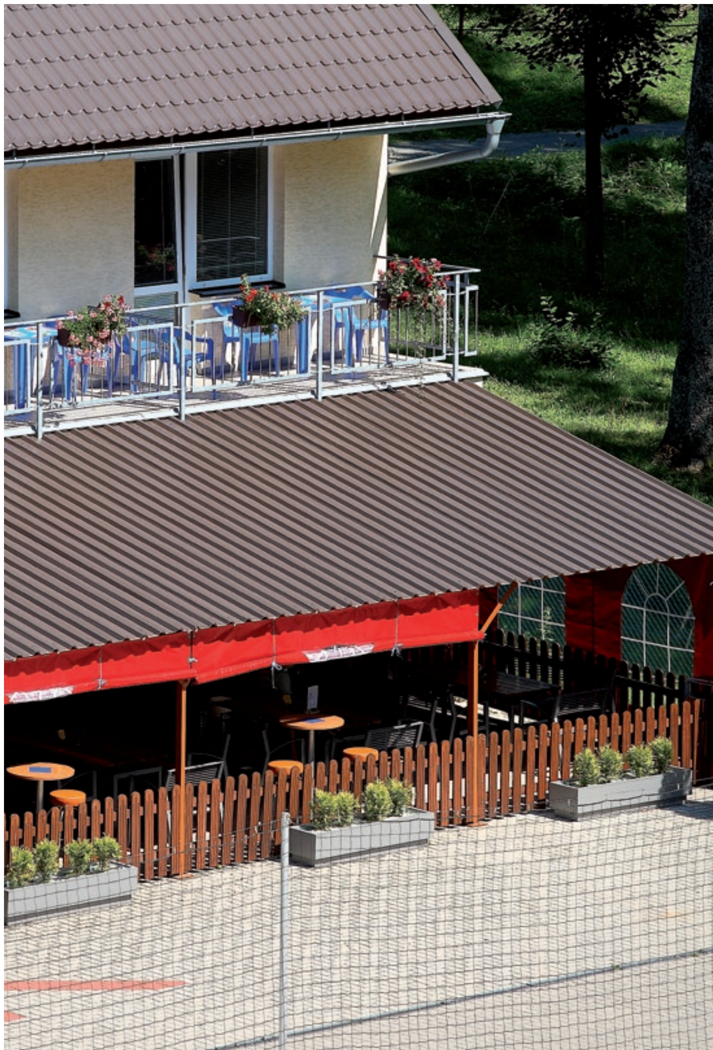
Realizace střešního systému Ruukki v Acrobat Parku Aleše Valenty (T35, PE, RR32)
